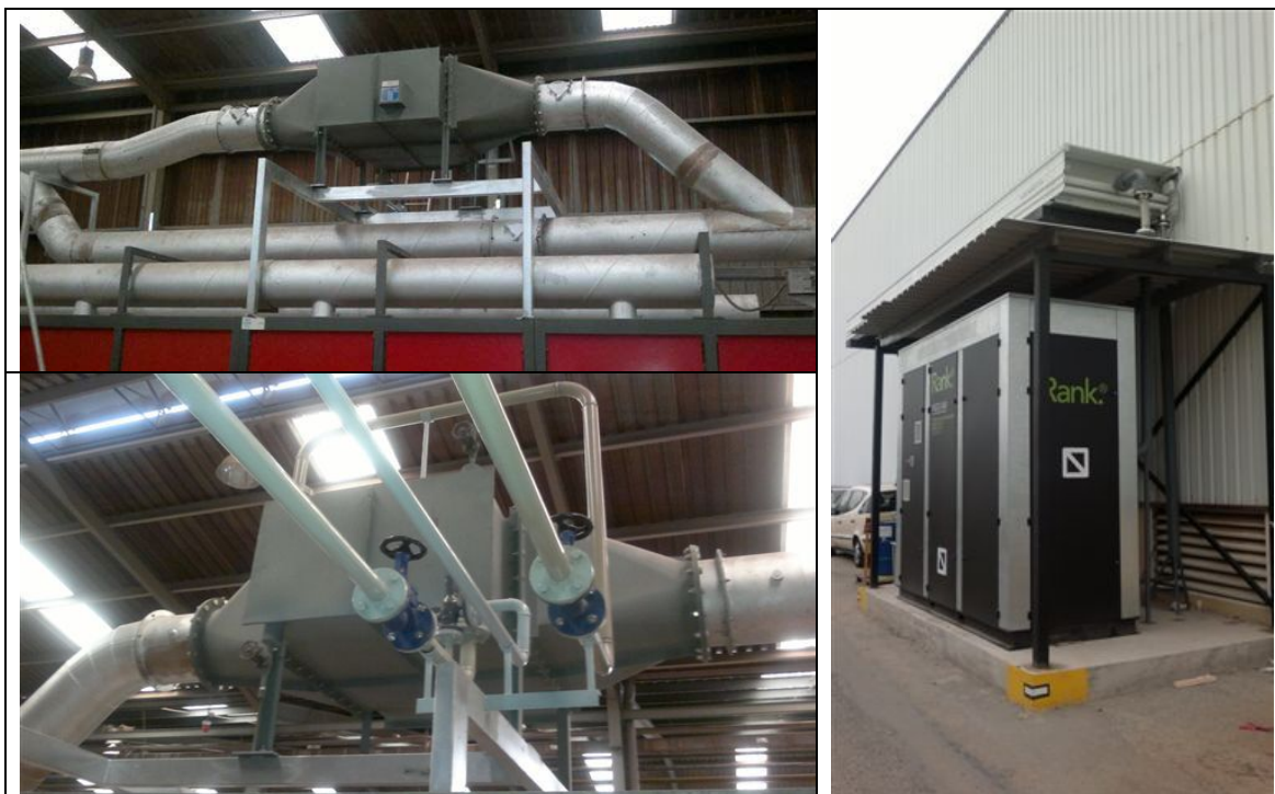
Imágenes de la instalación
